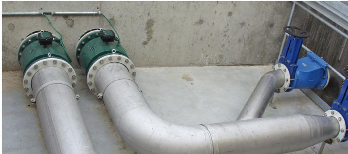
El Convertidor MagFlux® tiene una salida de 4 - 20 mA, dos relés para el control y alarmas, una entrada digital para reiniciar el lote o las alarmas, teclado para inicio o detención de los contadores de lote y para reinicio de los contadores, totalizadores y alarmas.
